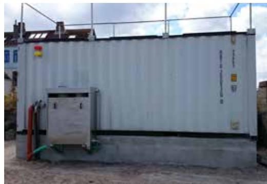
*Speziell für den Einsatz auf der Lotseninsel konzipiert: die Kläranlage wurde mit allen erforderlichen technischen Einrichtungen in einem Container untergebracht.*
