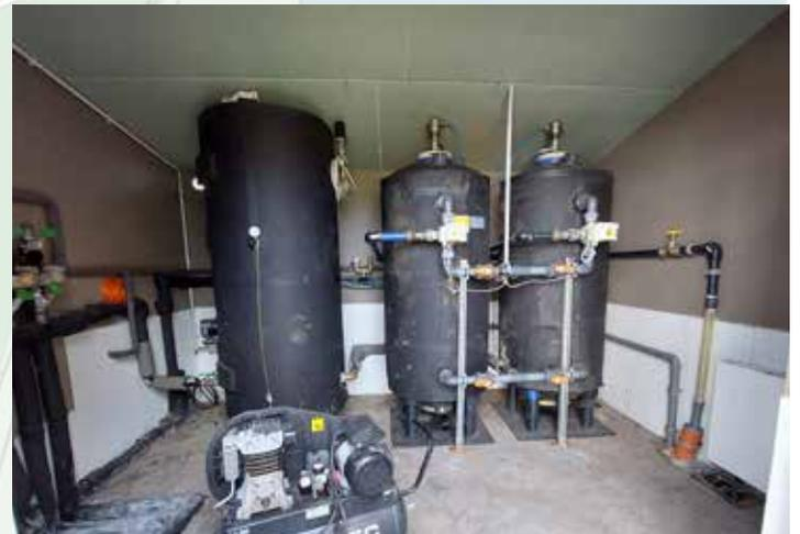
*in einer technischen Anlage über zwei große Kiesfiltersäulen aufbereitet und in das Trinkwassernetz der Lotseninsel abgegeben.*
